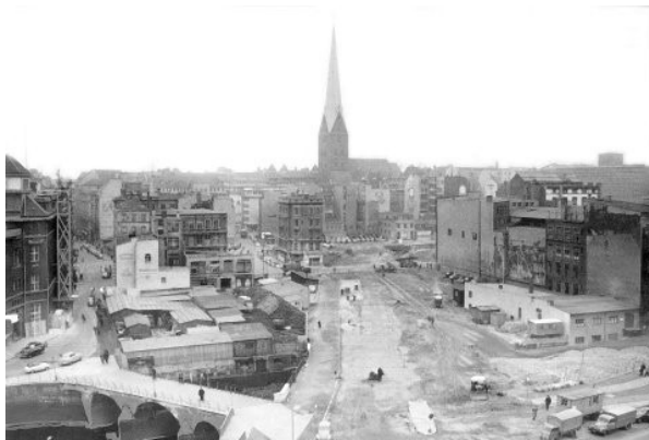
Eine zwei Kilometer lange, 36 Meter breite, sechsspurige Schneise durch die Stadt: Bau der Ost-West-Straße im Jahr 1956 Foto: ullstein bild
