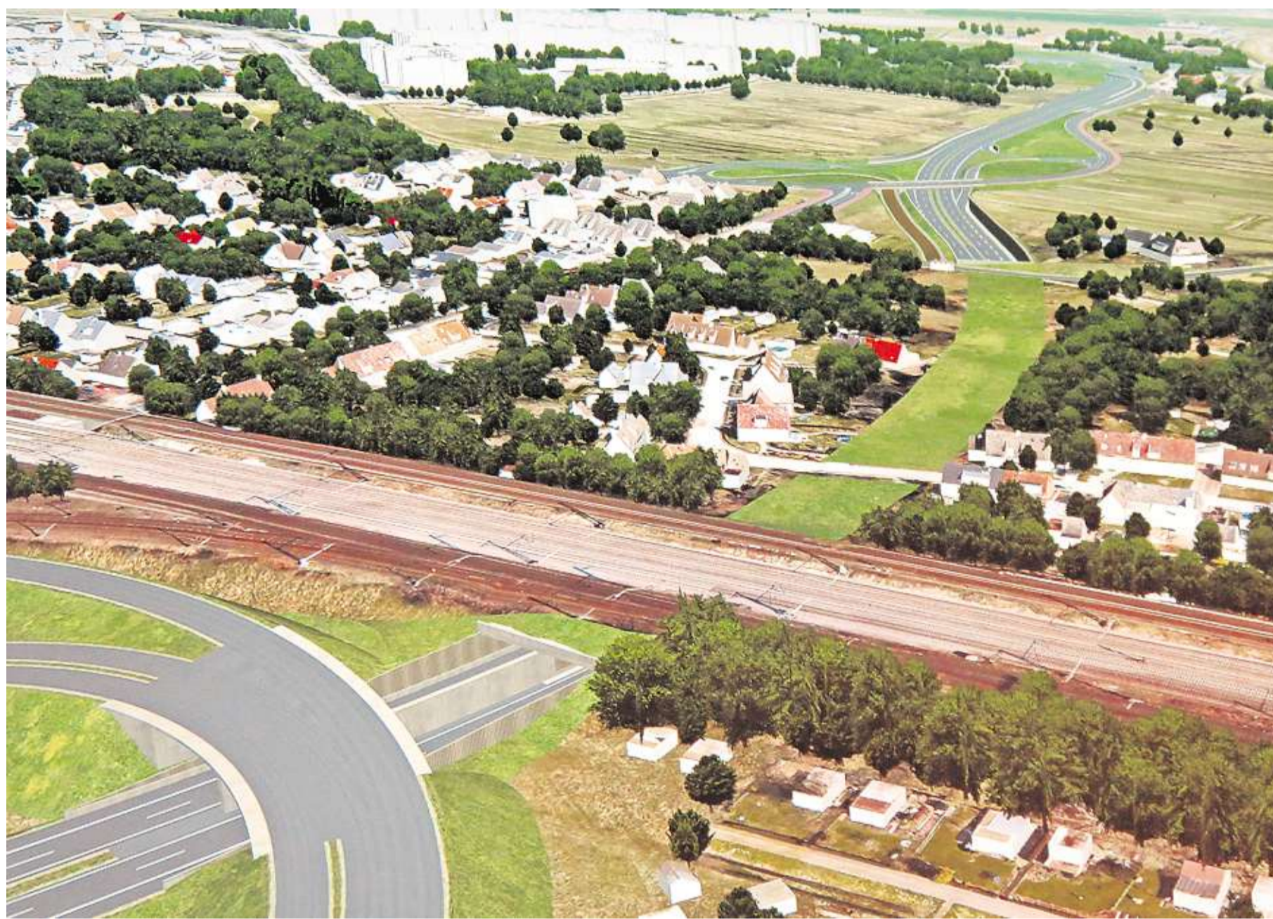
Die Visualisierung der DEGES zeigt grob den noch ungestalteten Autobahndeckel entlang der Siedlung Katenweg in Kirchdorf
