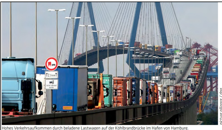
Hohes Verkehrsaufkommen durch beladene Lastwagen auf der Köhlbrandbrücke im Hafen von Hamburg.
