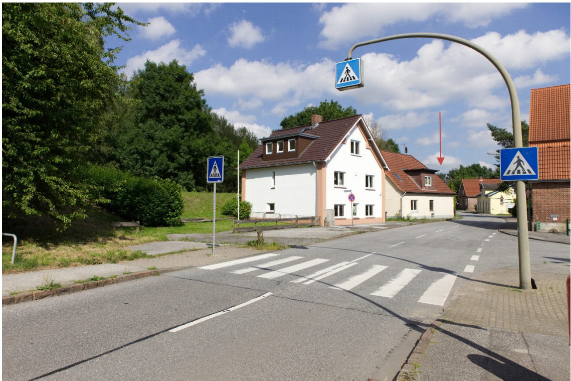
Abb. 20 Blick vom Moorburger Elbdeich weiter westlich Richtung Kraftwerk Moorburg mit A 26 (Fotomontage, der Pfeil kennzeichnet die Lärmschutzwand auf der A 26)
