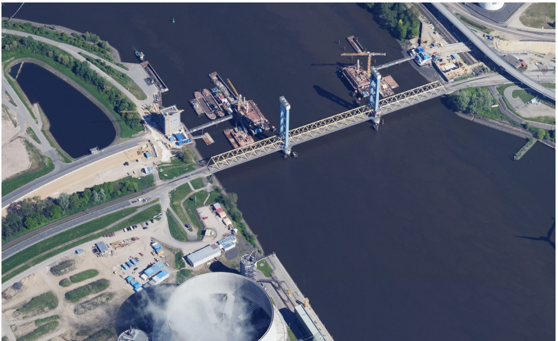
Abb. 10 Die Süderelbe im Bereich Kattwykbrücke 2018, die Neue Bahnbrücke Kattwyk (NBK) befindet sich im Bau (Quelle: www.geoportal-hamburg.de )
