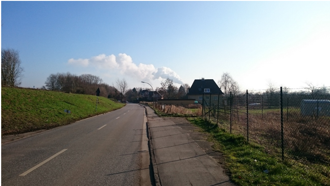
Abb. 24 Blick vom Moorburger Elbdeich Höhe Einfahrt Entwässerungsfelder Moorburg-Mitte Richtung Osten (Februar 2019), das rd. 2 km entfernte Kraftwerk an sich ist kaum sichtbar, nur die Dampfschwaden sind sehr gut erkennbar
