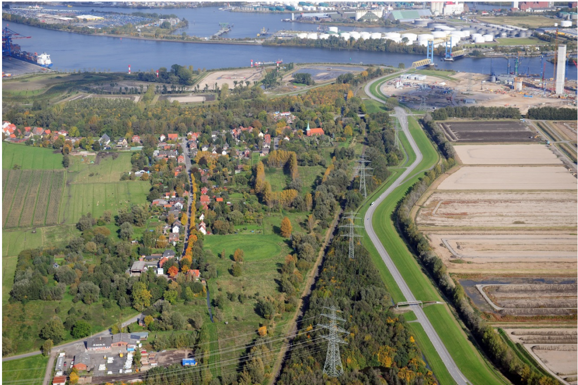
Abb. 7 Landschaftsbildensembles Moorburg Kattwykbrücke (Aufnahme 2008, Kraftwerk Moorburg noch im Bau)
